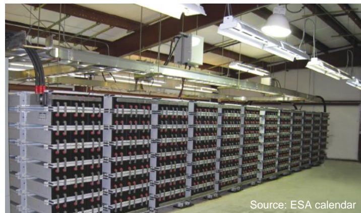
Metlatakla, PbA, 1 MW, 1.5 MWh
