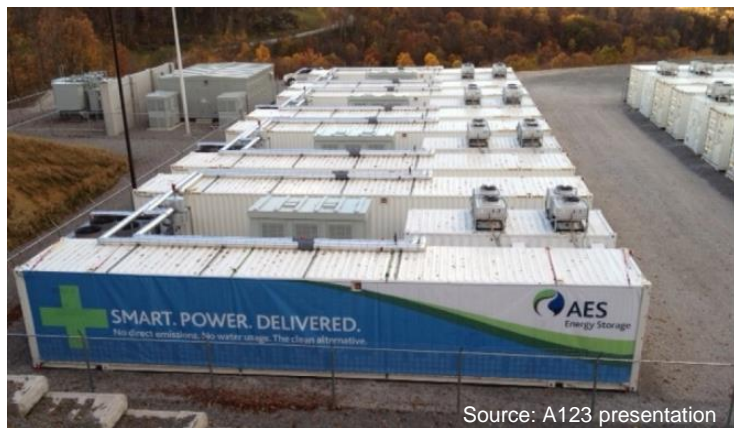
AES Laurel Mont., li-ion, 32MW, 8MWh
